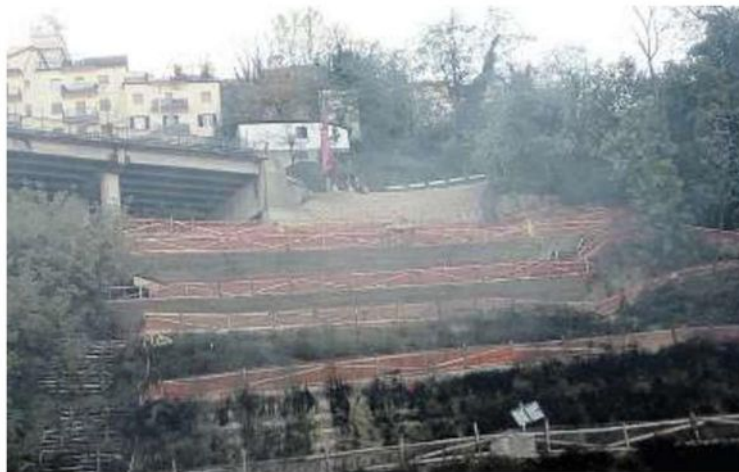
Di lato l'ascensore fuori servizio. Sopra i lavori per il viadotto
